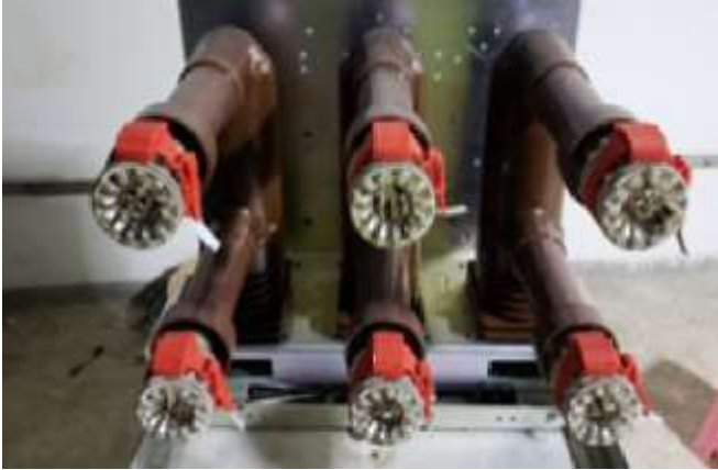
Рисунок Б.3– Пример монтажа датчика TOPAZ DT RS485 WSC
